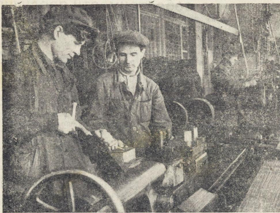
Слесари-стахановцы механической мастерской И. К. Харитонов (слева) и А. М. Захаров за капитальным ремонтом токарного станка. Производственную программу выполняют на 130 проц.
